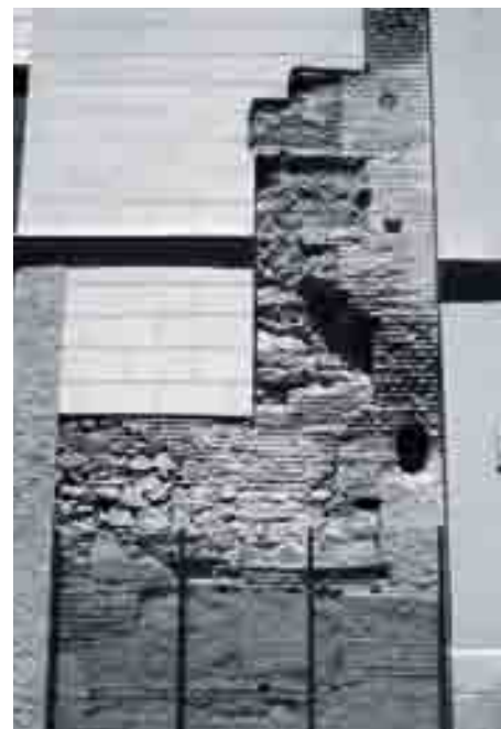
Integración de la Torre del siglo XIII en la fachada de la librería.
